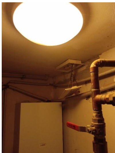
Obrázek č. 5 - Svítidlo s odpadlým krytem v prostoru kotelny a vodárny
