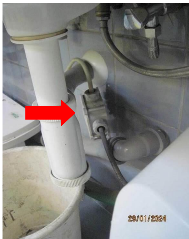
Obrázek č. 7a a 7b - Neupevněná elektrická rozbočná krabice pod umývadlem
