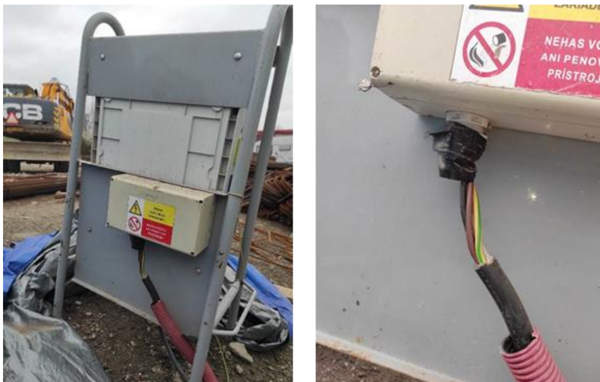
Obrázek č. 9a a 9b - Pohyblivý přívod není v místě připojení do elektrického rozvaděče zajištěn proti vytržení a zkroucení žil
