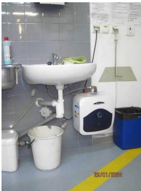
Obrázek č. 7a a 7b - Neupevněná elektrická rozbočná krabice pod umývadlem
