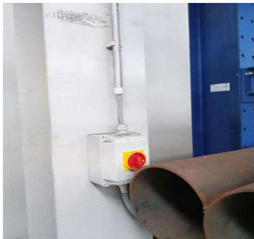
Obrázek č. 10 - Nepřístupný hlavní vypínač
